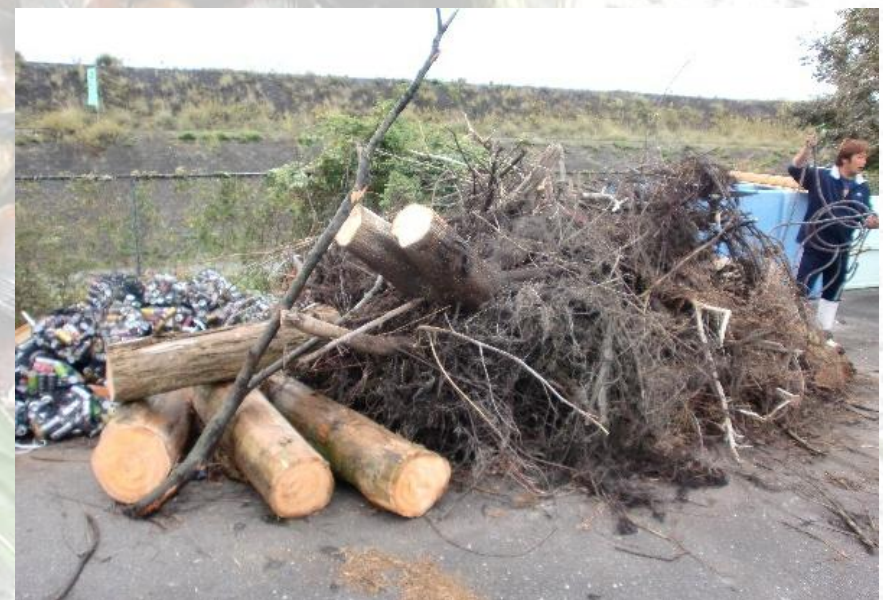
撤去作業を行いました
